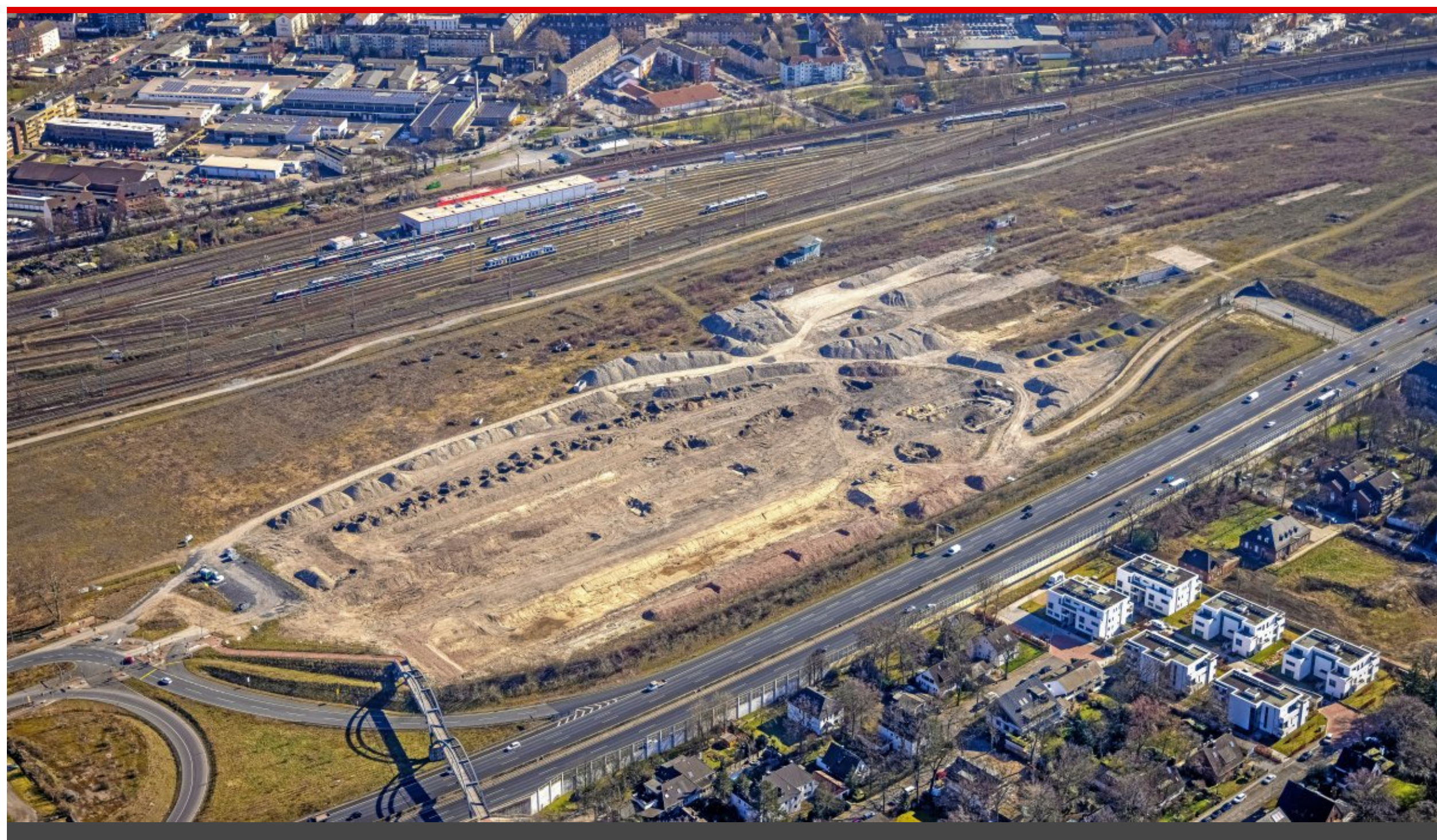
Auf der 30-Hektar-Brache des Alten Güterbahnhofs in Duisburg soll in den nächsten zehn Jahren ein innovatives Stadtquartier entstehen. Die Hallen auf dem Loveparade-Gelände zwischen A59 und Bahnstrecke sind inzwischen abgerissen. Foto: Hans Blossley / www.blossley.eu
